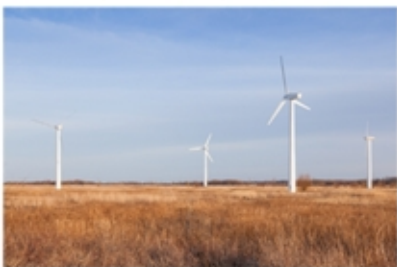
(2) Pembangkit Listrik Tenaga Angin
