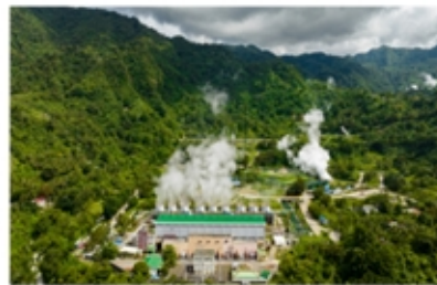
(3) Pembangkit Listrik Tenaga Panas Bumi
