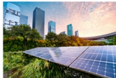
(4) Pembangkit Listrik Tenaga Surya
