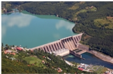
(1) Pembangkit Listrik Tenaga Air
